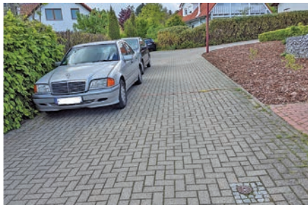
Wie hier auf der Adlerwarte im Rischkamp bleiben nur etwa 2,40 m Durchfahrtsbreite.
